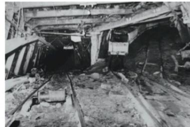
軌道分岐点 左側直進下り方向が本坑 右側方向が片 (中山啓氏所蔵)
