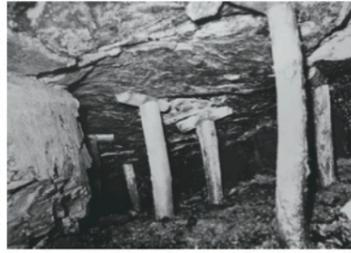
上部の岩盤を支える支柱と残柱亜炭 (左)
